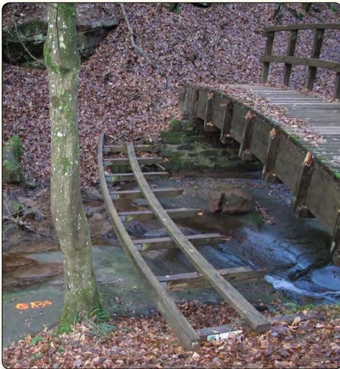
Für die Laufhölzer (Maße: 4x9, 5x85 cm mit Seilführung) der Hängebrücke war der Aufwand für einen geeigneten Ersatz wesentlich höher. Nach Versuchen mit Recyclingmaterial, sollte tropisches Hartholz zur Reparatur der morschen Laufhölzer verwendet werden.
